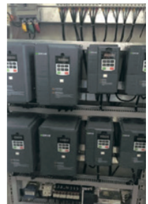
Система очистки воды
